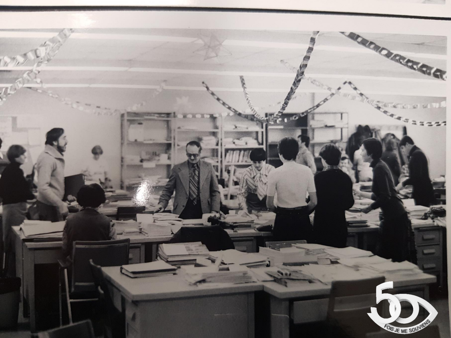
ARCHIVE photo de la salle des enseignants au début des années 1970.
